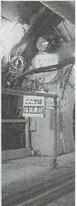
シールド後部のバルクヘッド。上部のアー
