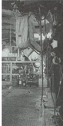
正面が親機、側面が子機が掘進している様子
