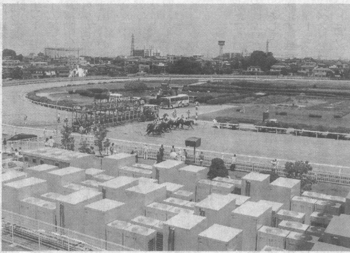
屋外設置した氷蓄熱式ユニット「エコアイス」群
